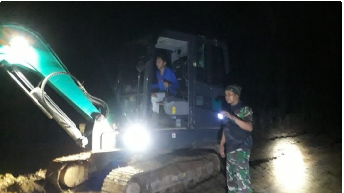
Jelang Akhir, Satgas TMMMD Ke 116 Kodim 1004/Kotabaru Terus Kebut Sasaran Jalan
