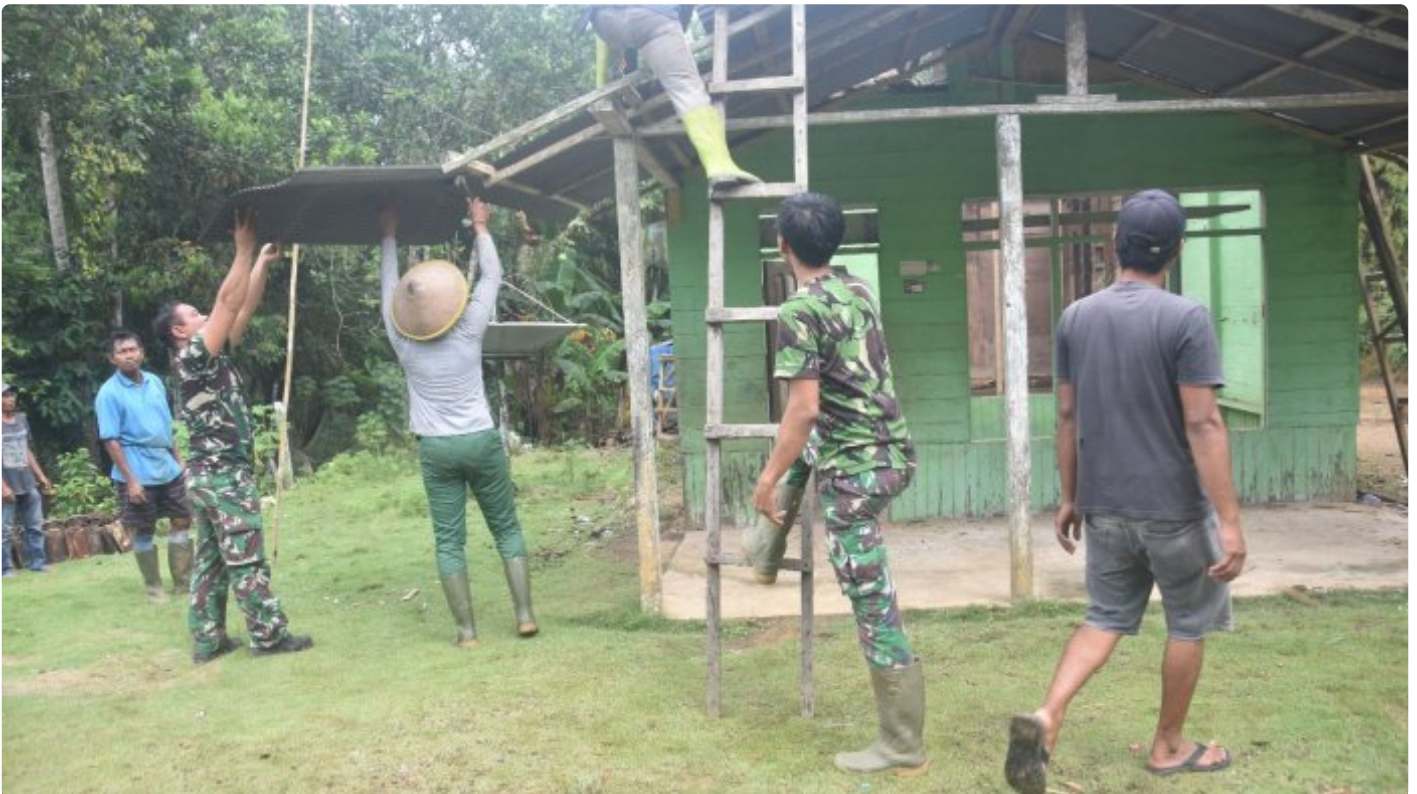
Satgas TMMMD 116 Kodim 1004 Kotabaru Terus Pacu Perehaban Rumah Tidak Layak Huni
